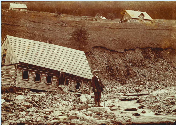
Fotografie von F. Joffé. Das Haus in St. Peter im Riesengebirge wurde durch die Kraft des Wassers stromabwärts getragen. © Archiv Pavel Scheufler
