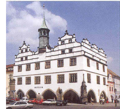
Museumsgebäude in Leitmeritz/Litoměřice
